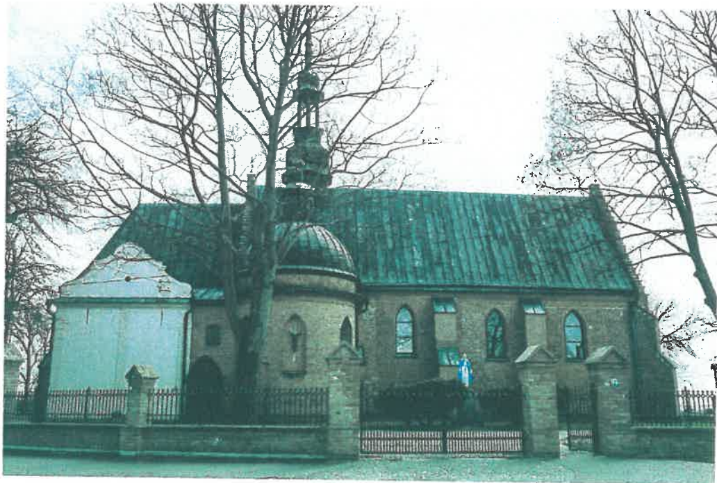
Fot. nr 1 Kościół parafialny p.w. św. Mari Magdaleny w Tarnobrzegu-Miechocinie. Widok świątyni od strony północnej.
