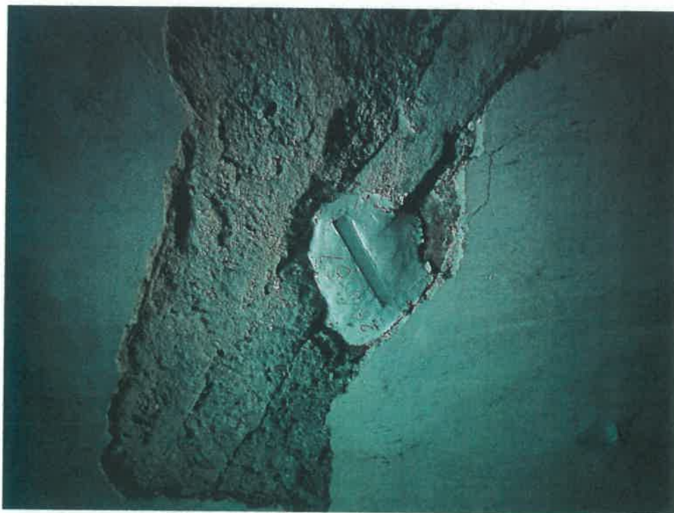
Fot. nr 19 Kościół parafialny p.w. św. Mari Magdaleny w Tarnobrzegu-Miechocinie. Widok nienaruszonej próby szklanej z dnia 26 marca 1987 roku.
