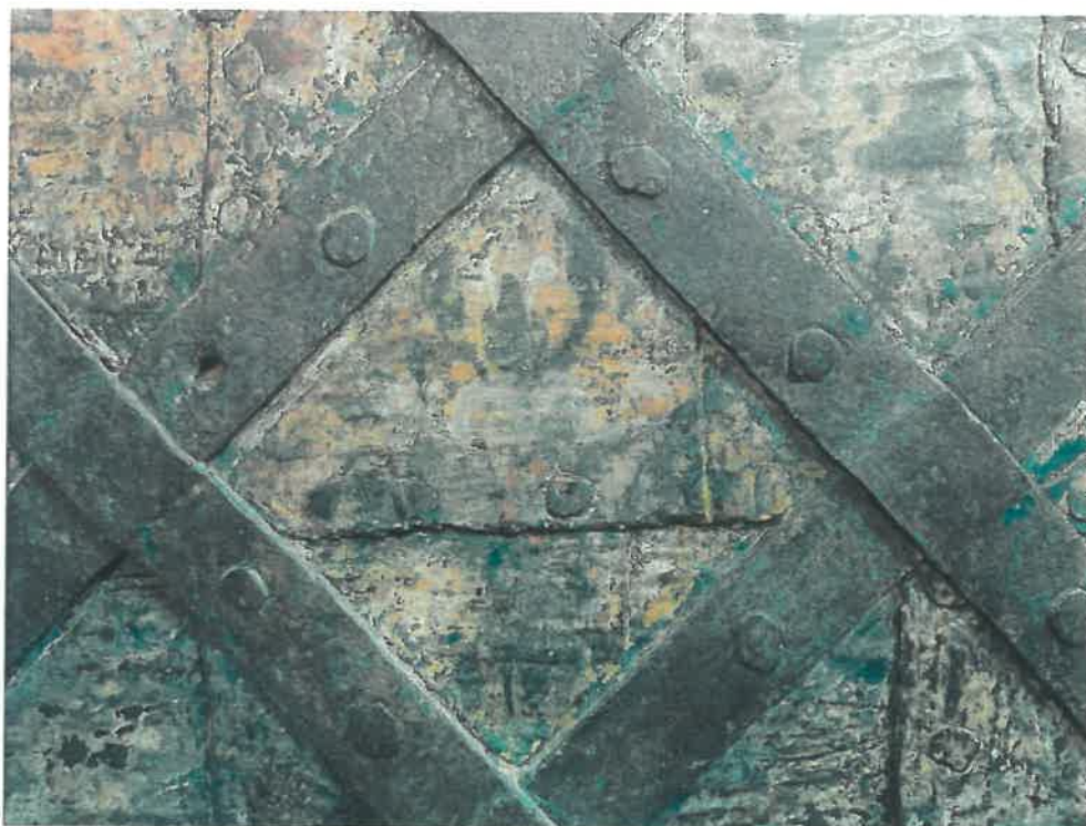
Fot. nr 14 Kościół parafialny p.w. św. Mari Magdaleny w Tarnobrzegu-Miechocinie. Widok uszkodzeń warstw malarskich na okuciu stolarki drzwiowej drzwi zakrystii.
