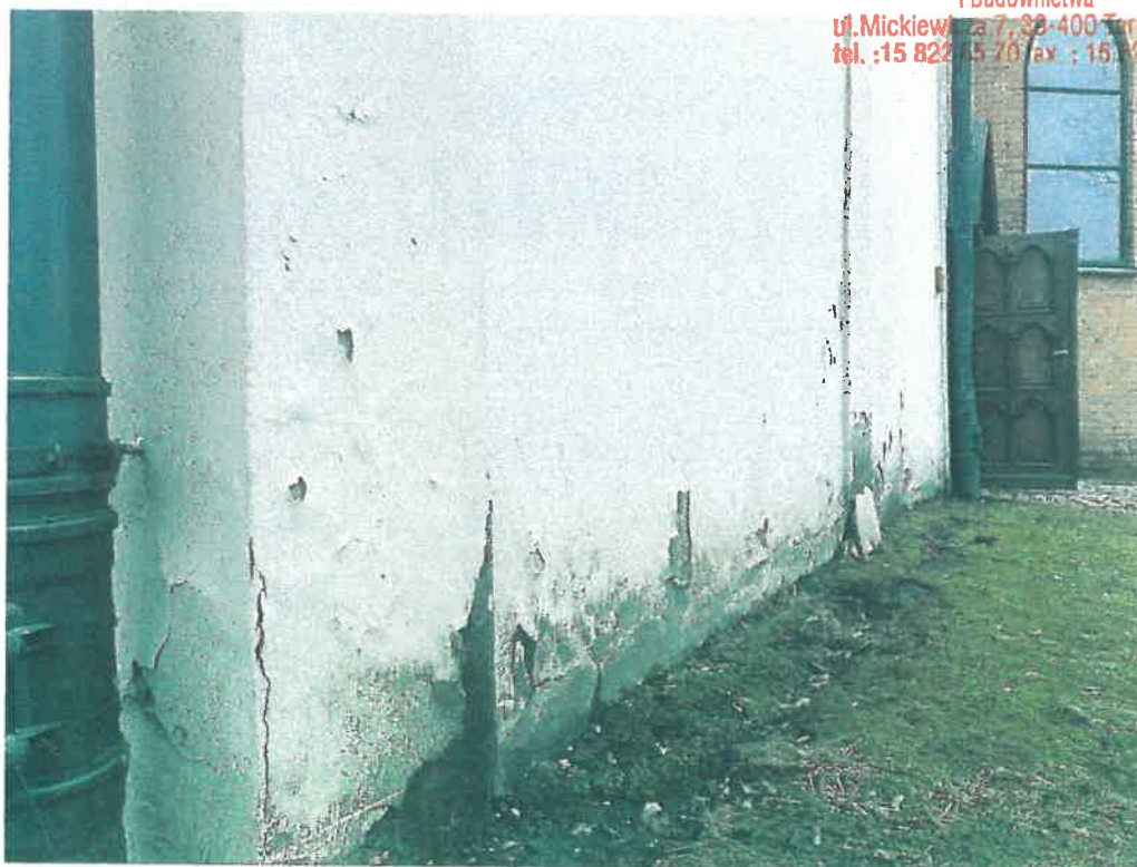
Fot. nr 4 Kościół parafialny p.w. św. Mari Magdaleny w Tarnobrzegu-Miechocinie. Widok zniszczeń wypraw tynkarskich w strefie cokołowej zakrystii.
