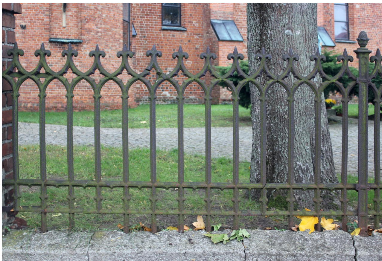
FOT. 6: Fragment zabytkowego przęsła
