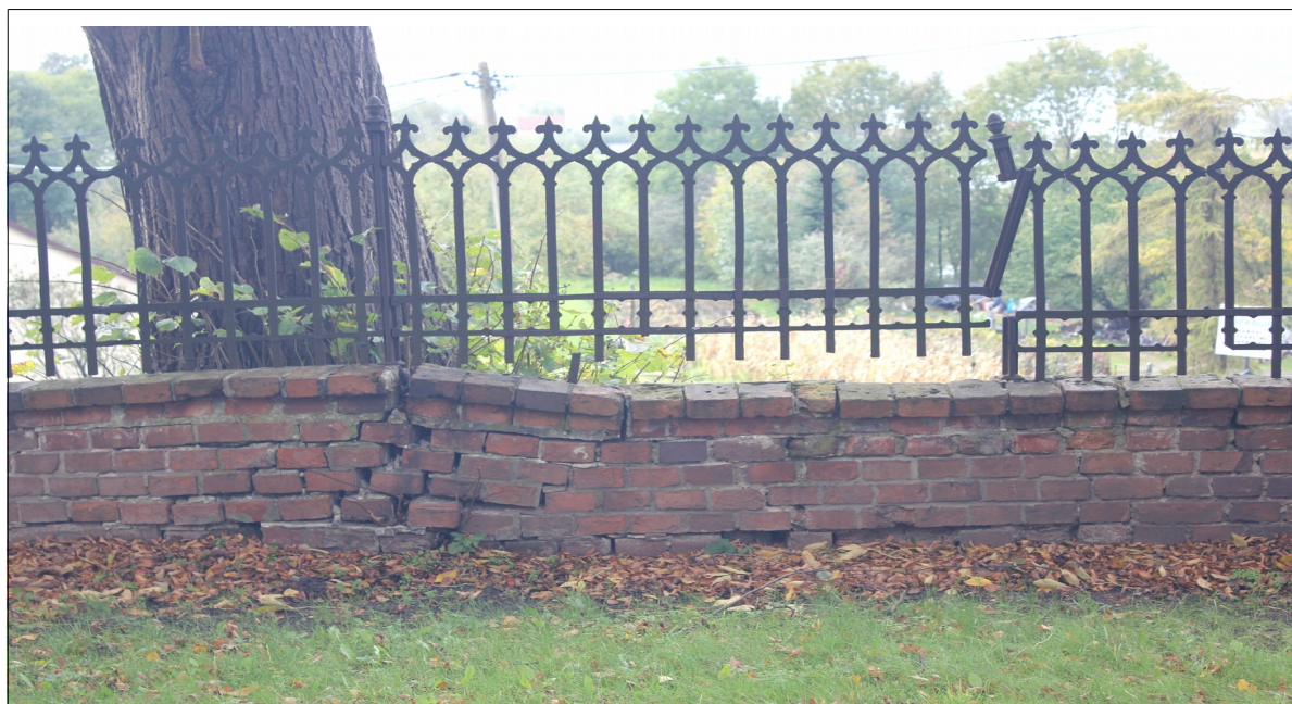
FOT. 5 Stan istniejący ogrodzenia
