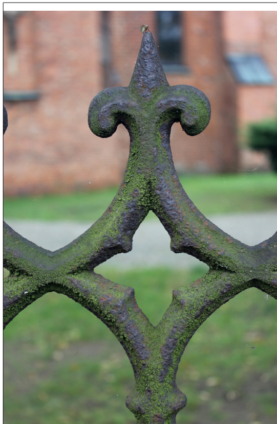
FOT. 1 Detal zabytkowego przęsła
