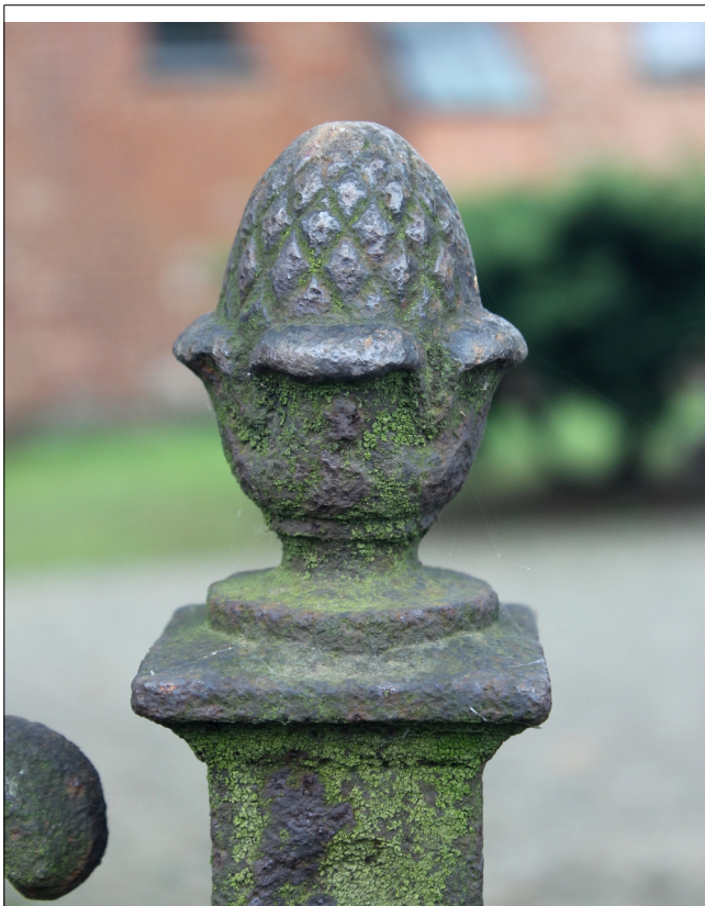
FOT. 2 Detal zabytkowego przęsła (zwieńczenie słupka)
